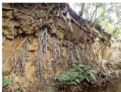
＜根系発達による表層の崩落＞
