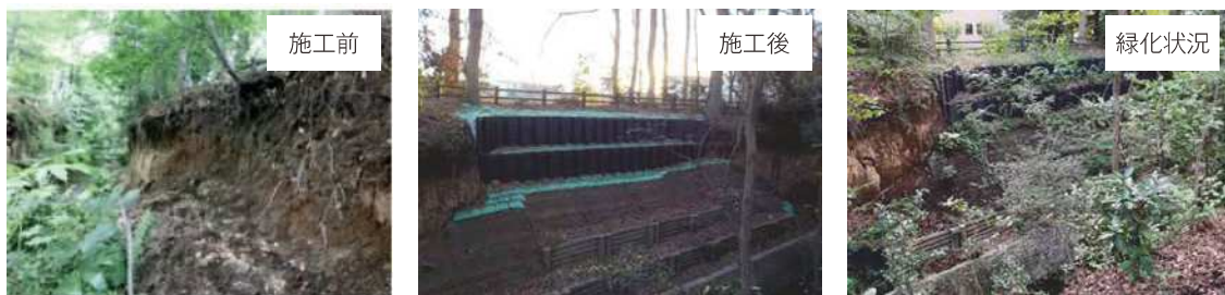
＜木柵工による法面保護工実績：西中島橋下流（右岸）＞
