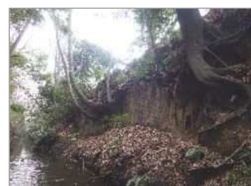
＜オーバーハング状法面に生育 (a)＞
