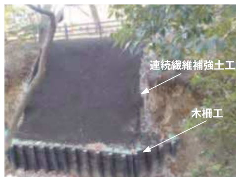
写真-10 法面保護工施行例
