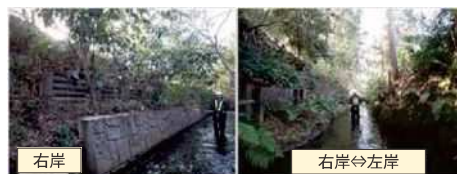
右岸 牟礼橋～兵庫橋 ＜コンクリート擁壁、擬木柵＞
