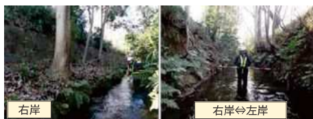
右岸 長兵衛橋～牟礼橋 ＜コンクリート擁壁＞
