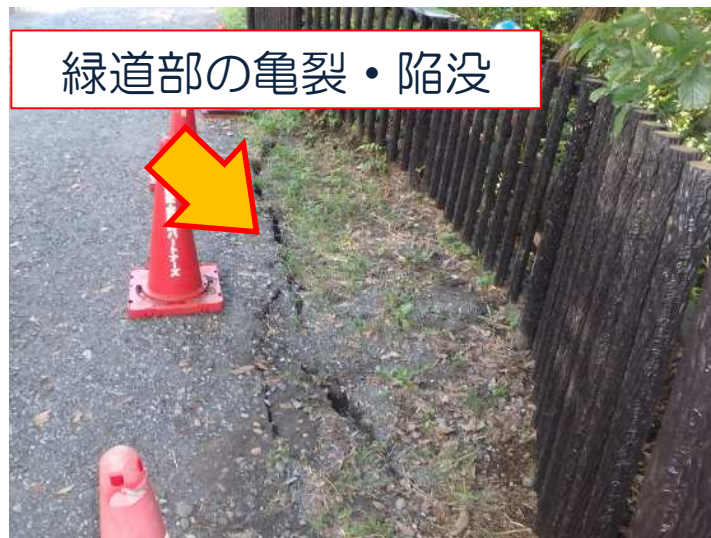
【緑道部の状況】
