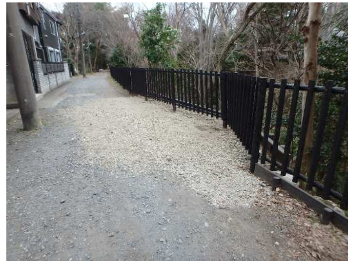
【応急復旧工事完了（令和5年2月末）】
