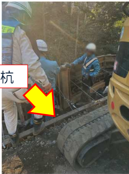
【控え杭の打設・ワイヤー固定】
