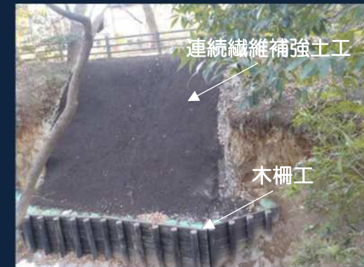
素掘り法面を保護するための工事
