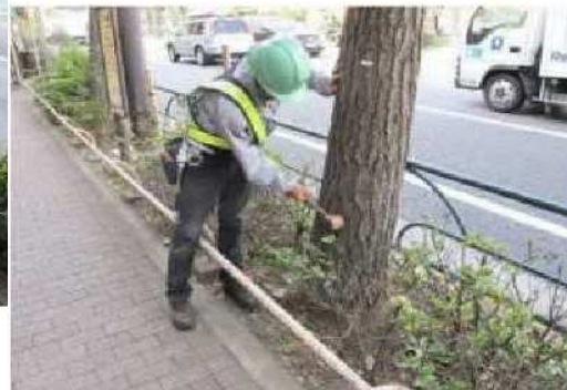
● 木槌打診音の異常の確認
