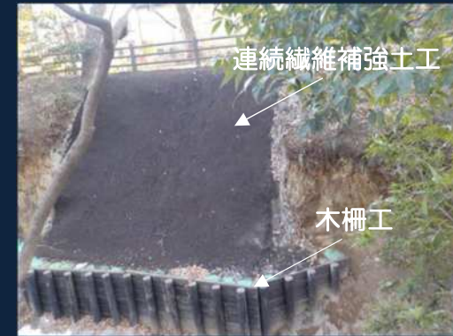
素掘り法面を保護するための工事
