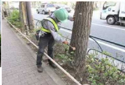
●木槌打診音の異常の確認
