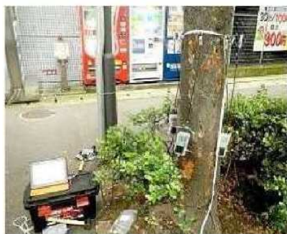
○ 機器設置状況
