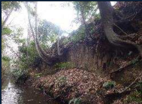
<オーバーハング状法面に生育(a)>
