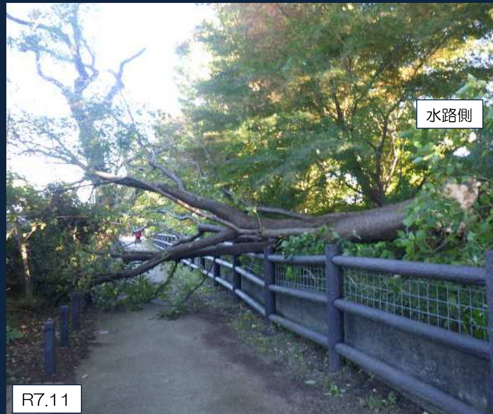
【岩崎橋（杉並区）付近】
