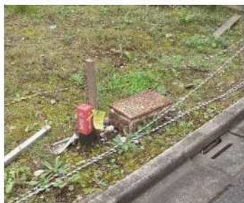
＜使用見込みがないまま 放置されている給水管＞
