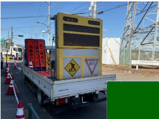
○ソーラー式工事標示板の活用
