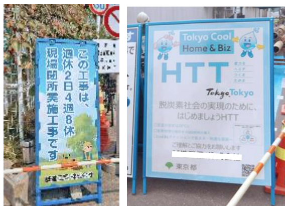
○働き方改革、HTT をPR する看板を設置
