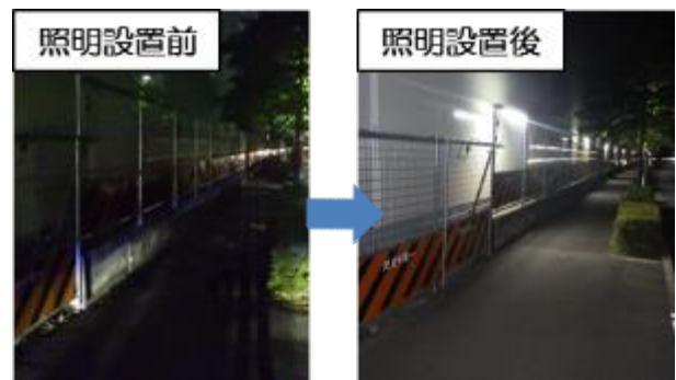
○歩行者の安全確保のため、歩道に照明設置
