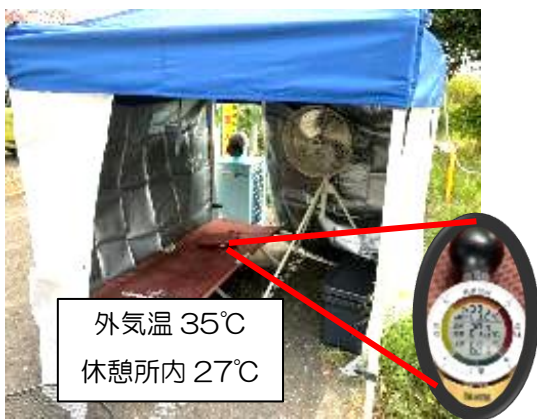
○遮熱シートで覆った休憩所の設置
