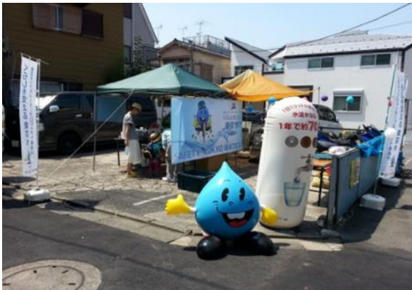
○工事現場周辺に休憩所を設置、水道工事に対するアンケートを実施
