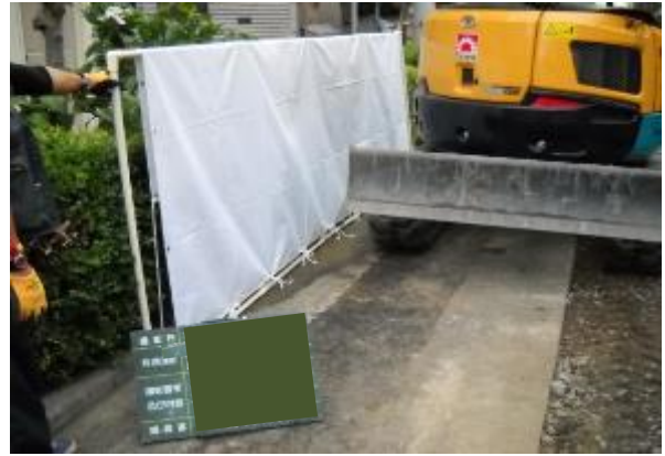
○移動が容易な「熱枯れ防護柵」を設置
