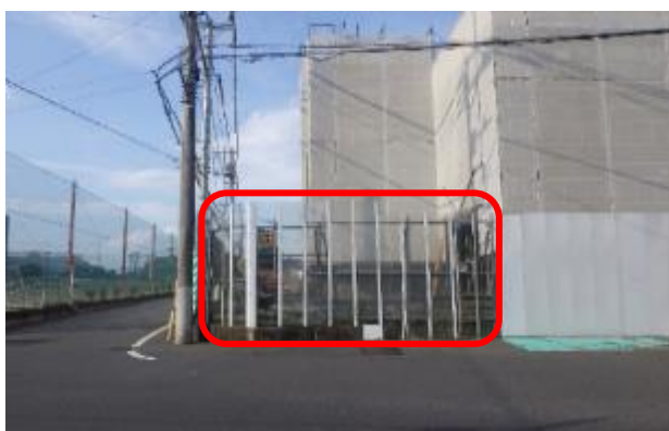
○コーナー部の仮囲いに透明パネルを採用し見通し確保
