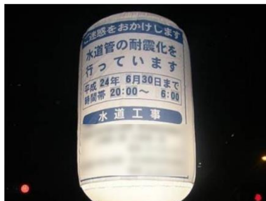
○バルーンライト型工事看板
