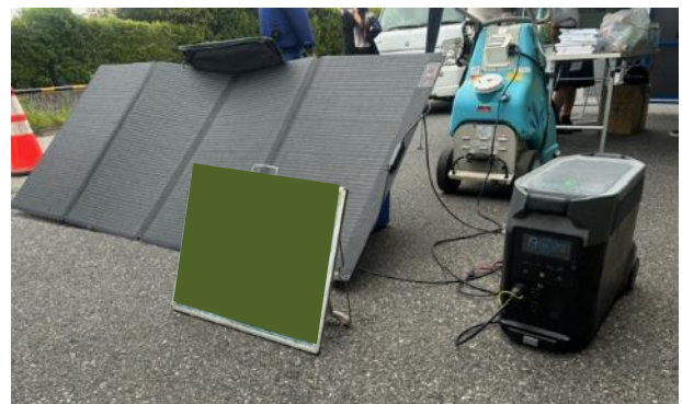
○太陽光パネルにより蓄電池へ充電し、 電力を夜間案内板に活用
