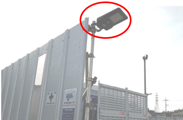
○材料置場、出入口にセンサーライトの設置
