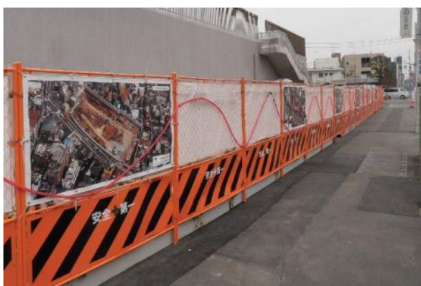
○施工当初からの航空写真と完成予想図を フェンスシートに掲示
