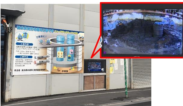
○デジタルサイネージにより、掘削状況等を情報発信
