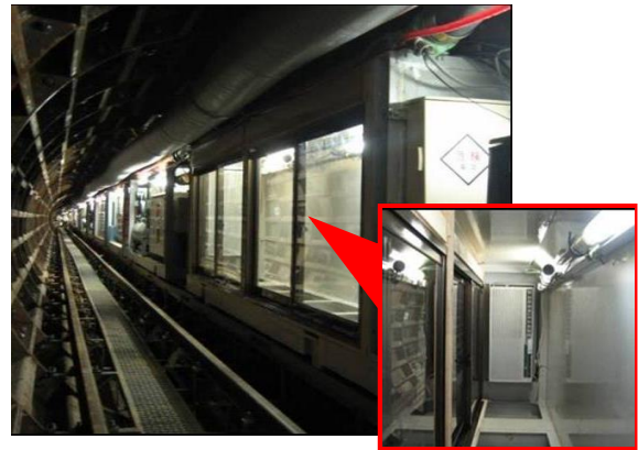
○シールドマシンの後続台車にエアコンを取り付けた休憩室を設置
