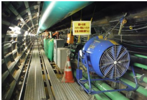
○トンネル内に送風機を設置
