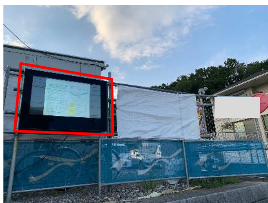
○工事の行程表や近隣の災害時給水ステーション 等の情報を発信
