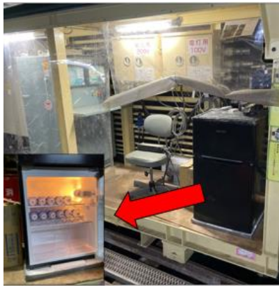
○シールド坑内に冷蔵庫を設置
