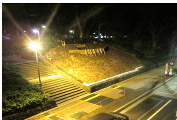
○低誘虫のナトリウム灯を設置
