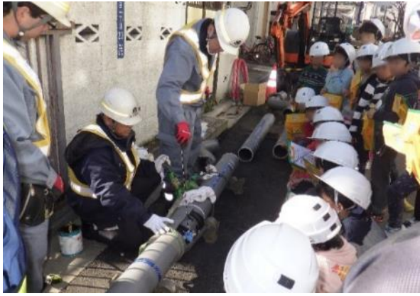
○耐震管継手を用いた配管作業の見学
