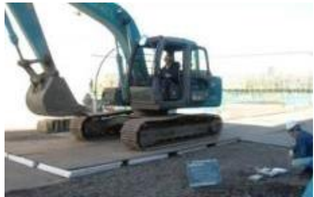
○発泡スチロール防振材の設置による騒音低減
