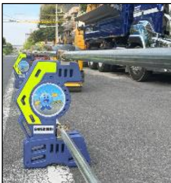
○反射材付きで安全性の高い単管バリケードを使用
