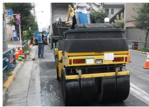
○仮舗装転圧時にローラーを使用し、騒音を低減
