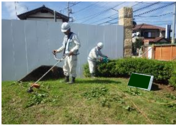
○施工現場内の公園整備
