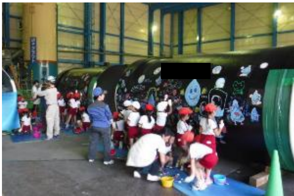
○近隣園児による水道管ペイント
