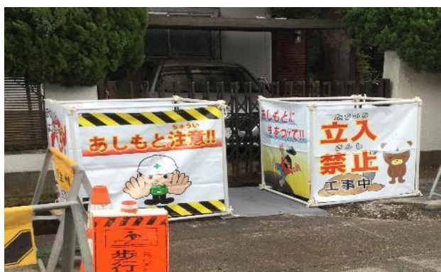
○オリジナル防護柵の設置
