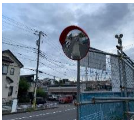
○資材置場出入口にミラーを設置し、視認性を確保
