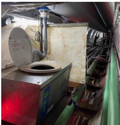
○シールド坑内にバイオトイレを設置
