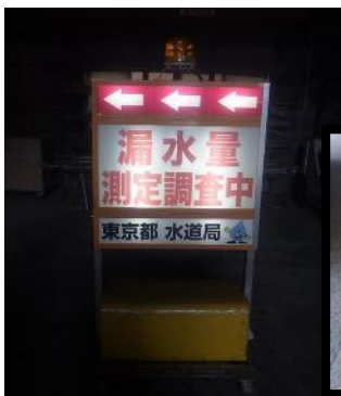
○内照式工事標示板（LED ライト）により 排気ガス・騒音の低減
