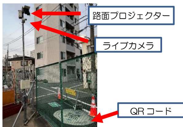
○工事概要の掲載だけでなく、ライブカメラによるリアルタイム配信を行う工事専用HPを開設し、QRコードをプロジェクターで路面に投影
