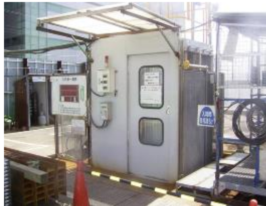
○立坑内用のエレベータを設置し 工事見学者も利用
