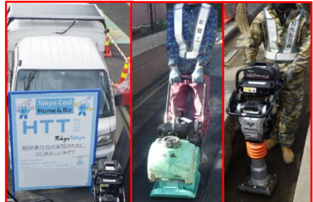
○ソーラーパネル発電とバッテリー式器具使用
