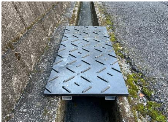
○歩行者通路内のU型側溝に、仮設の再生プラ製敷板を設置して安全確保
