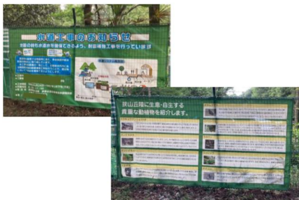
○工事情報と地元の動植物の紹介を隣接して 掲示することで効果的に工事をPR
