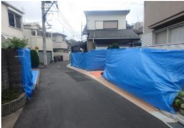
○現場周辺をビニールシートで養生
