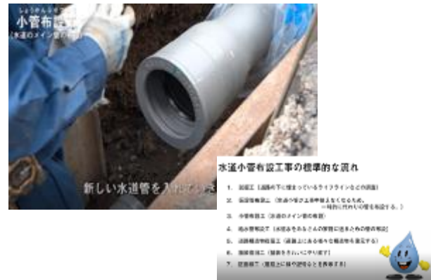
○水道工事の流れがわかる DVD を作成し、小学校に配布して PR
