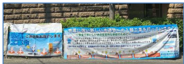
○植樹保護の養生マットに水道工に関する情報を掲載し PR
