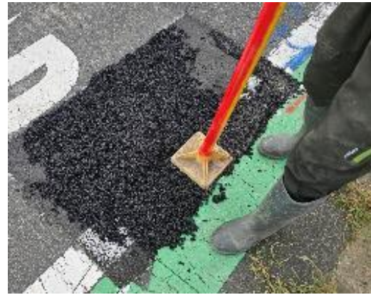
○植物由来原料でバイオマス認定を受けた 常温合材を活用
