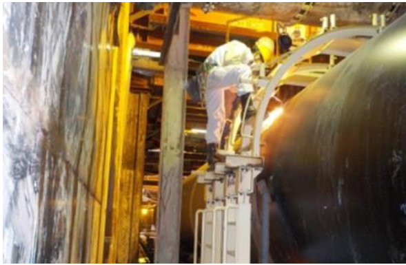
○大口径鋼管溶接用に移動式足場を製作
