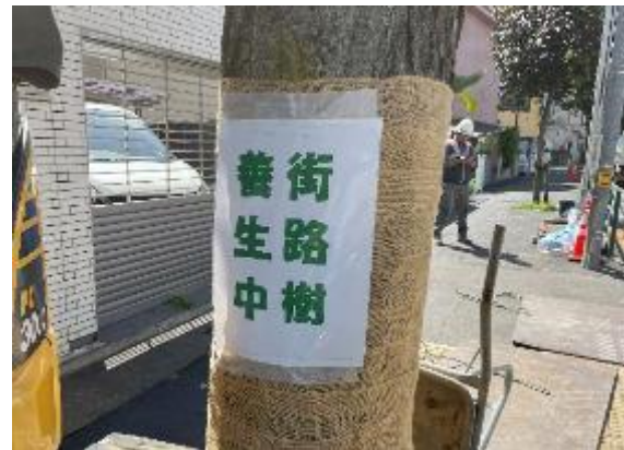
○現場沿道の街路樹を養生
