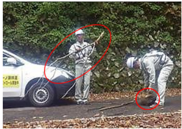
○林道にて倒木・転石の撤去作業
