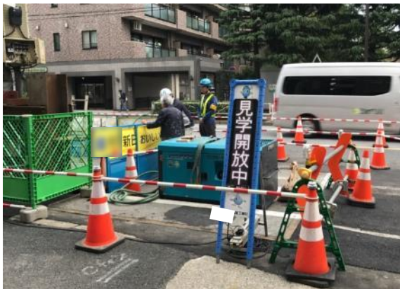
○現場見学エリアの設置
