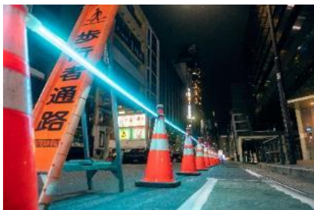
○光るコーンバーを作業帯に設置
