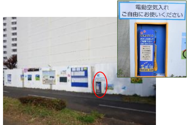
○工事現場の外側に電動空気入れを設置
