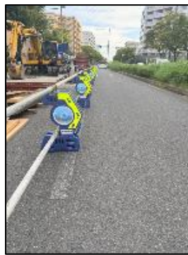
○歩行者通路内のU型側溝に、仮設の再生プラ製敷板を設置して安全確保
