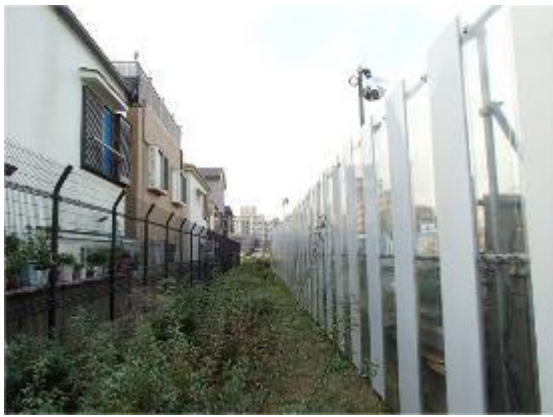
○圧迫感のない透明な仮囲いを設置
