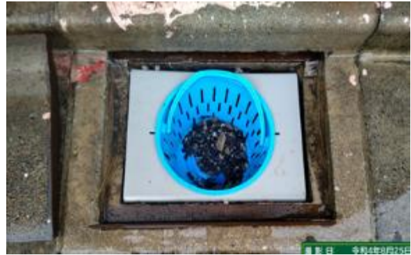
○雨水枳への土砂流入防止対策を実施
