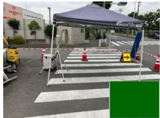
○テント、ミスト付き扇風機を設置
