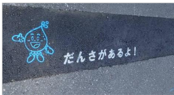
○仮舗装部のつまづき事故防止のための注意喚起
