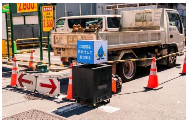
○視認性の高いLED 看板を設置
