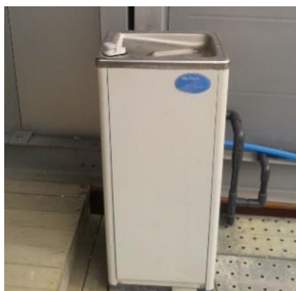
○冷水器の設置
