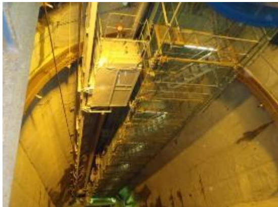
○立坑用の昇降階段の脇にエレベータを設置
