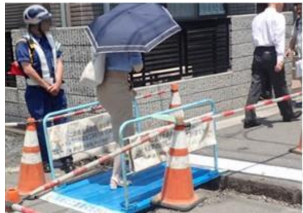
○安全通路（鋼製棧橋）の設置
