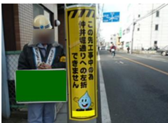
○高輝度工事予告看板を設置
