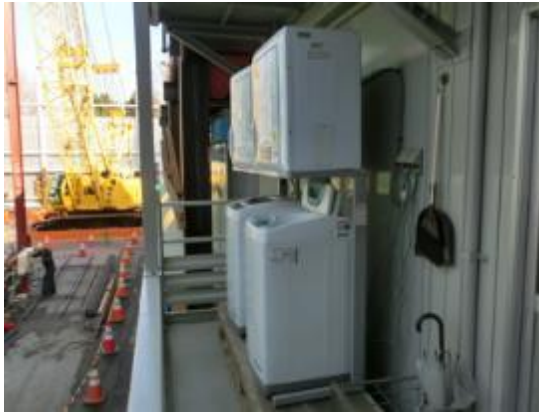
○洗濯機・乾燥機の設置
