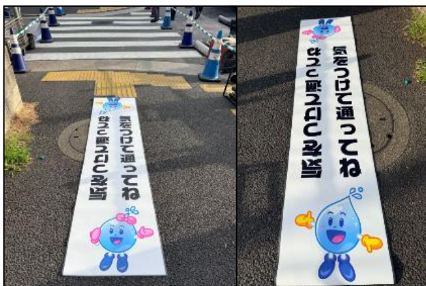
○作業帯に近接する横断歩道手前に歩行者用マットを設置し、注意喚起
