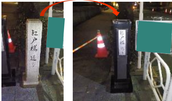
○沿道の石碑を養生し工事の影響を低減
