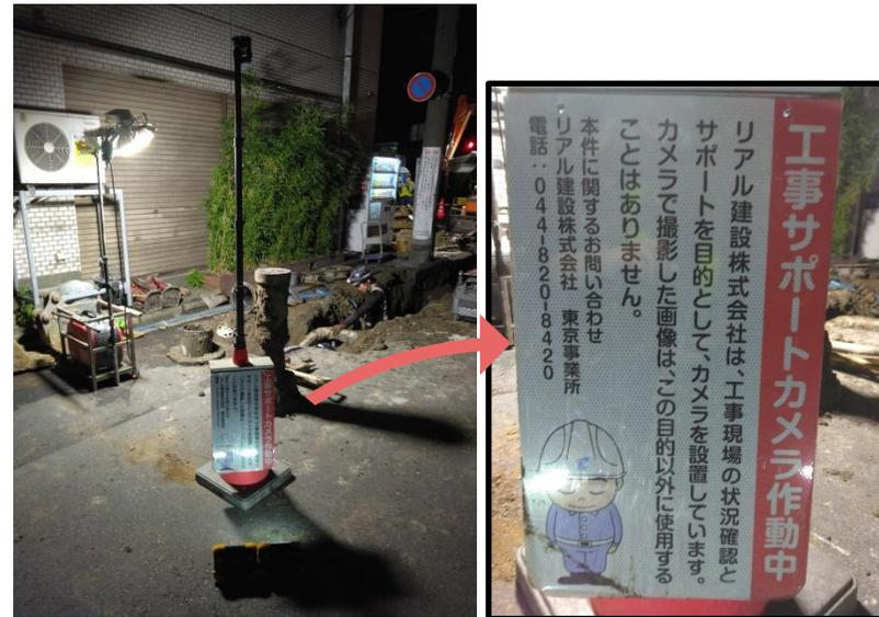
工事サポートカメラの設置による、遠隔確認により、現場管理の効率化及び安全性が向上
