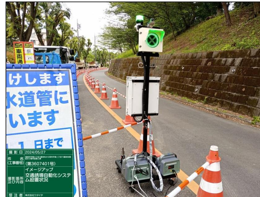
視認性が低い車道でAIと高性能センサーの活用により、渋滞を発生させずに一般車両を誘導
