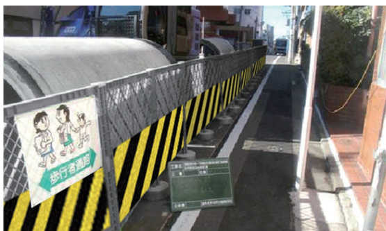
用塑料围栏区隔通道
