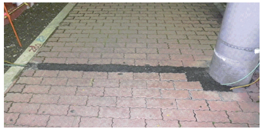
电缆埋设在地下
