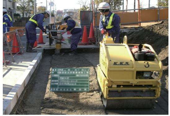
压路机与作业人员进行的压实作业 (密集作业非常危险)
