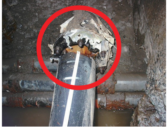
Ống bị tuột ra do không lắp đặt biện pháp bảo vệ.
