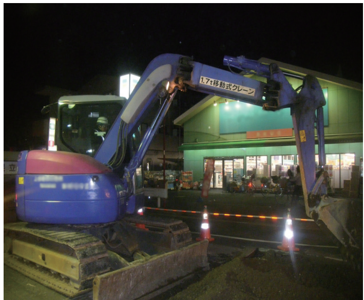
Backhoe dengan fungsi derek
