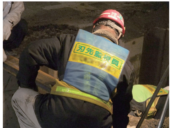
Pengawas pekerjaan galian manual pendahuluan
