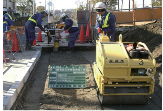
Pekerjaan pemadatan oleh roller dan pekerja (Pekerjaan yang tumpang tindih sangat berbahaya)
