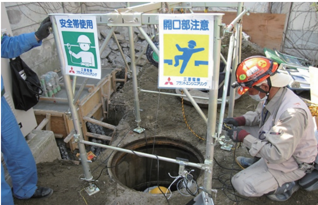
Tindakan pencegahan jatuh ke dalam lubang manhole.
