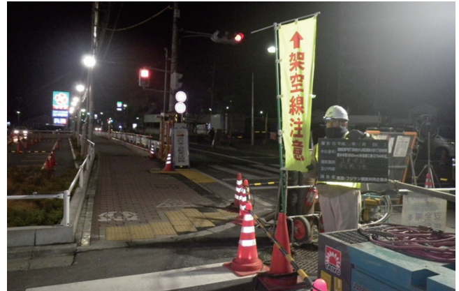
Pemasangan "Hati-hati Kabel Udara" di atas permukaan tanah
