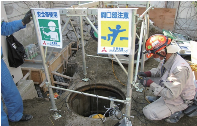
မန်ဟိုးအတွင်းသို့ ပြုတ်ကျမှုကာကွယ်ရေးအတွက် အစီအမံများ
