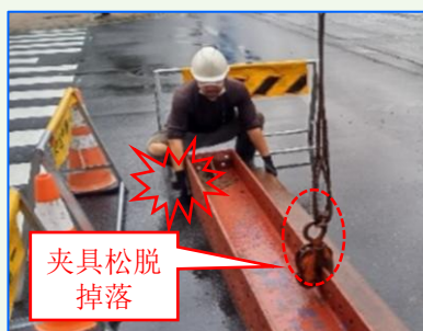
用手抓住H型钢材底部时受灾（2022年度）
