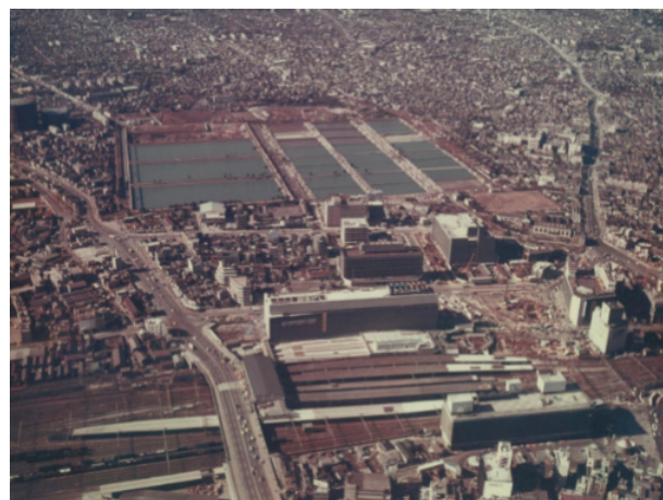
【写真1-10 廃止直前の淀橋浄水場】
