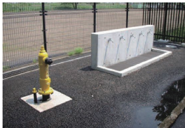
【写真2-12 応急給水拠点】
