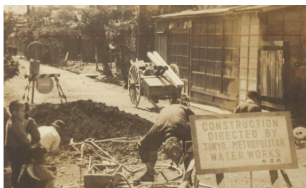
【写真1-7 戦後の復興工事】
