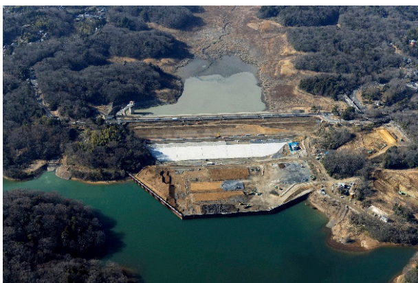
【写真3-4 村山上貯水池堤体強化工事】
