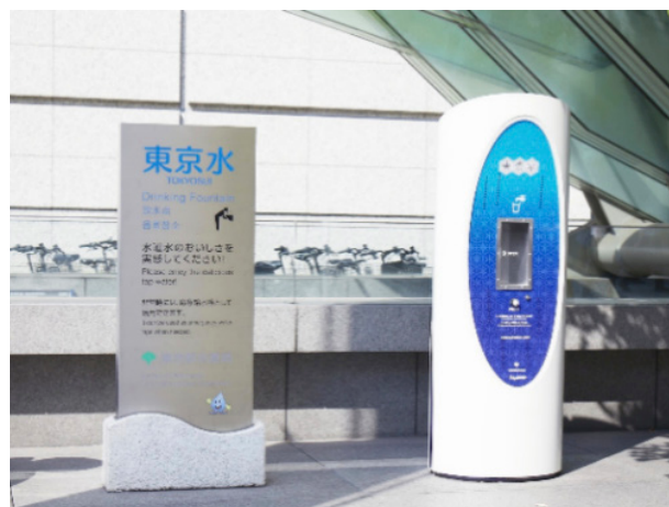
【写真3-5 TokyoWater Drinking Station】
