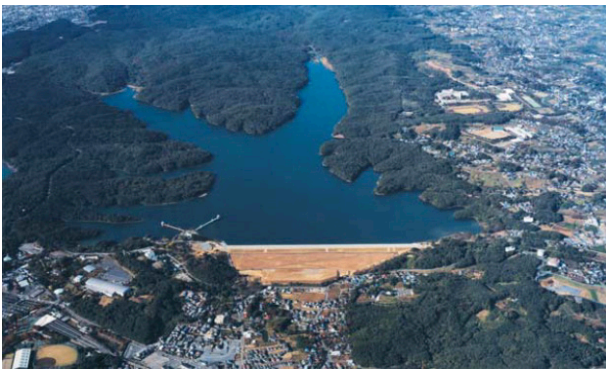
【写真2-9 山口貯水池（工事完了後）】
