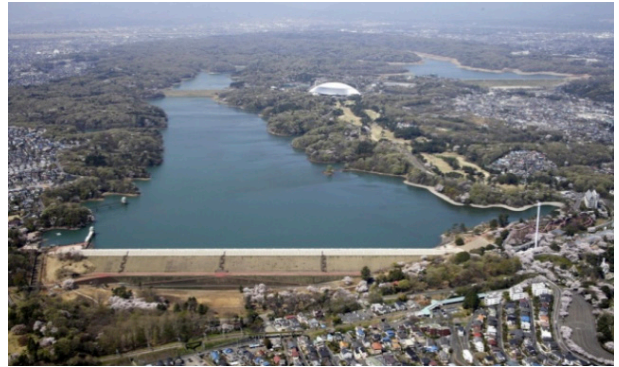
【写真2-10 村山下貯水池（工事完了後）】
