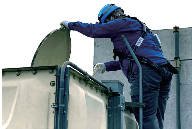
【写真2-4 貯水槽水道点検の様子】
