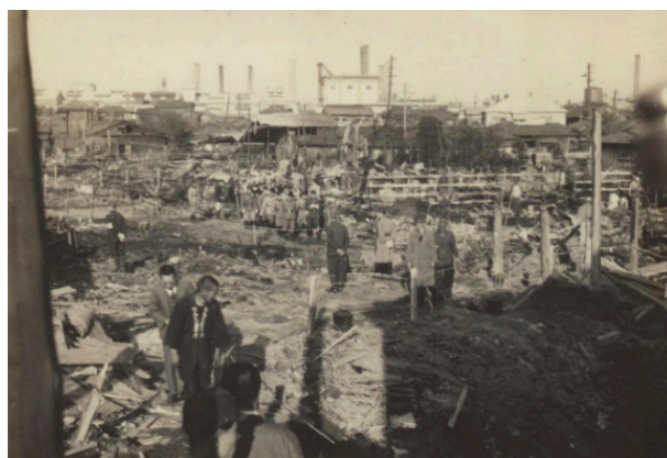
【写真1-6 戦災による水道施設への被害】
