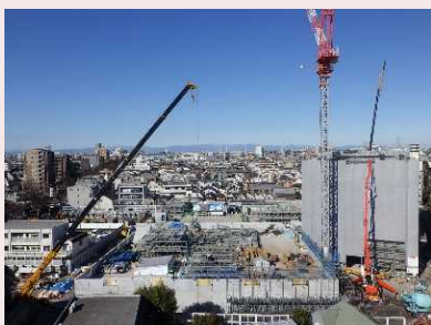
▲ 上北沢給水所(仮称) ポンプ棟築造状況
