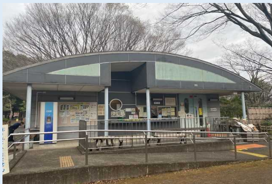
▲都立砧公園に設置されているシンボリックな水飲栓
