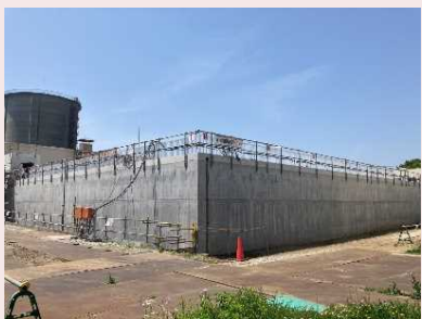
▲ 深大寺給水所 現在、計画どおり拡充工 事を行っています。
