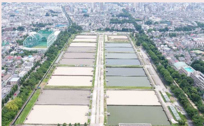
▲ 工事着手前の境浄水場
