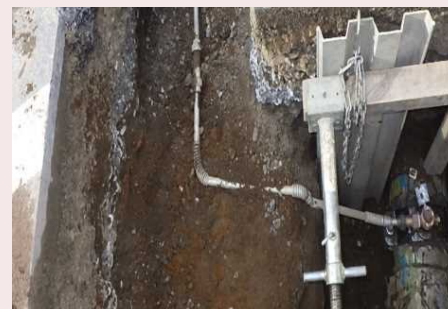
▲給水管撤去前
