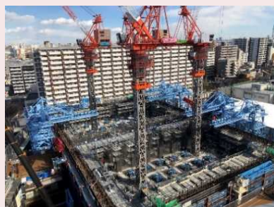
▲ 王子給水所(仮称) 配水池築造状況
