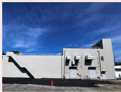
▲ 柴崎給水所 現在、計画どおり拡充工 事を行っています。
