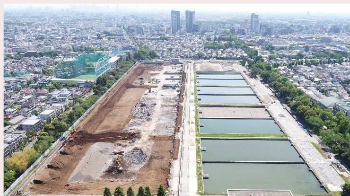
▲ 工事中の境浄水場 既存施設の撤去工事を実施しています。
