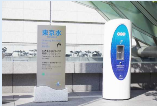
▲東京国際フォーラムに設置されているシンボリックな水飲栓
