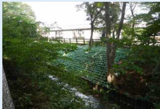
▲法面保護工事の実施（玉川上水） 流水や風雨等の影響により崩落や浸食を受けている法面を補強しました。
