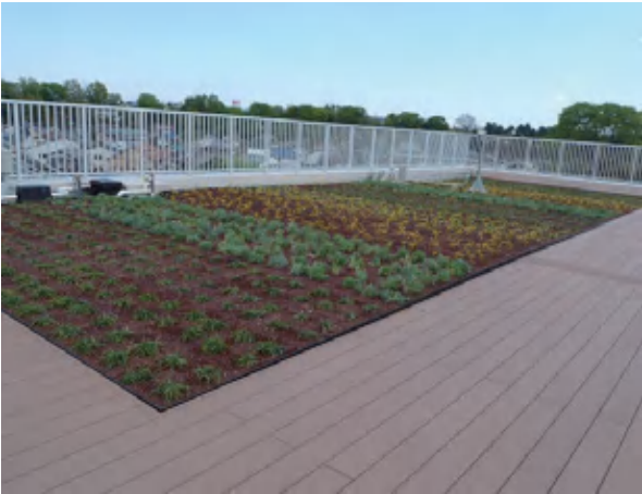
羽村取水所の屋上緑化
