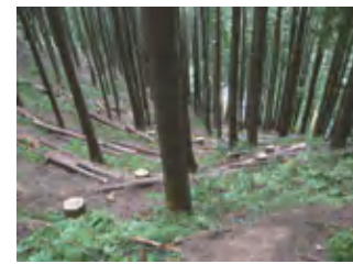
土留め材として利用
