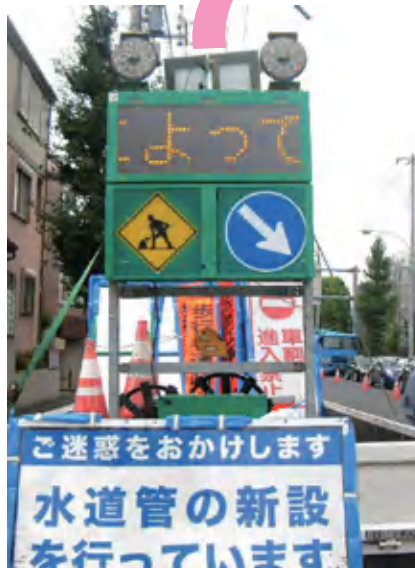
ソーラー式工事標示板の活用
