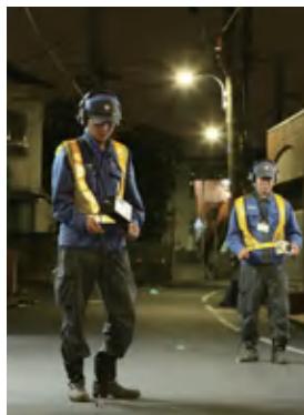
夜間を実施する音聴調査の様子 (地下漏水の早期発見)
