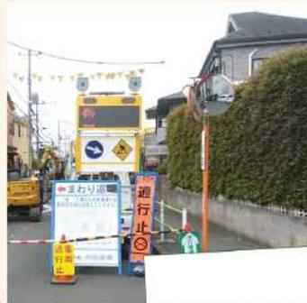
ソーラー型の LED 工事表示板を使用することで、環境負荷を減らしています。
