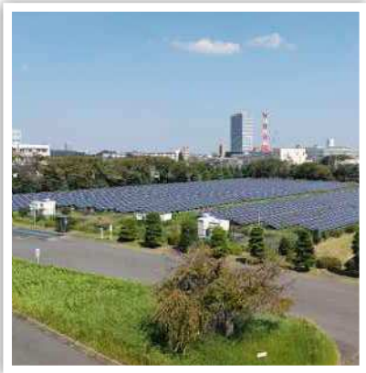
配水池上部の太陽光発電設備 （東村山浄水場）
