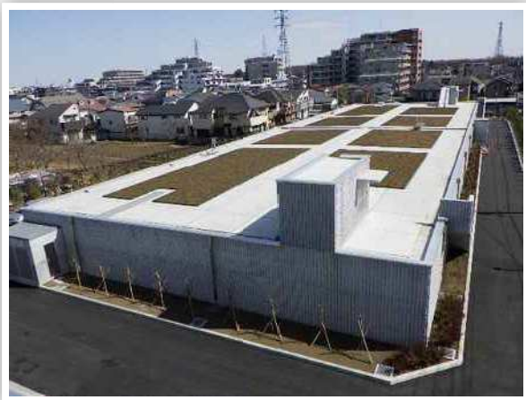
幸町浄水場の屋上緑化
