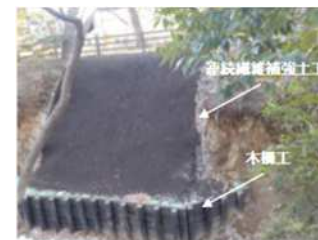
素掘り法面を保護するための工事
