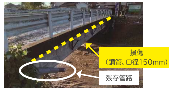
▲令和元年東日本台風による添架管の損傷 （東京都日の出町 玉の内橋）
