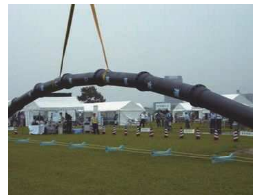
▲抜け出し防止機能を有する耐震継手管
