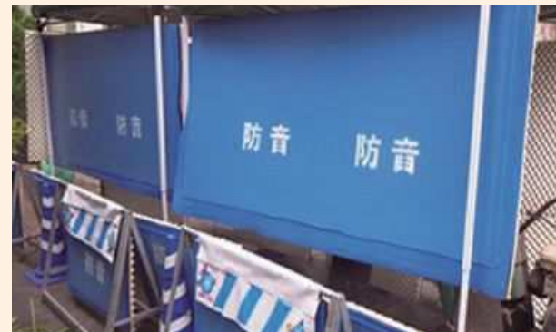
▲施工時の防音パネル設置
