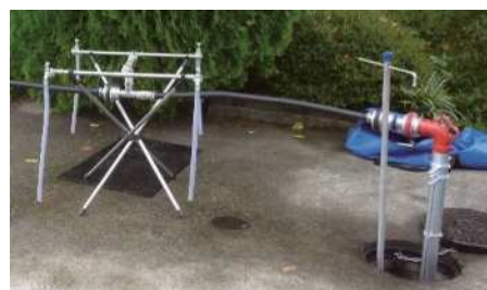
▲4口の蛇口を備えた資器材を設置
