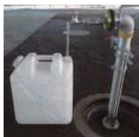
▲スタンドパイプによる応急給水
