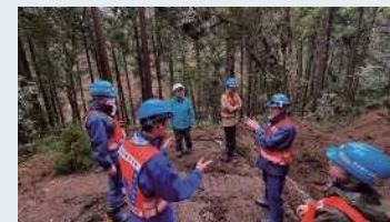
▲現場での復旧方法の打合せ
