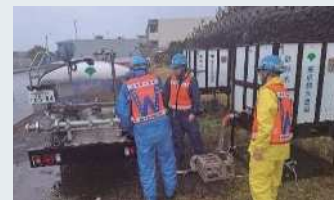
▲給水車から仮設給水槽への注水
