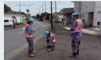
▲水量確保のための漏水調査
