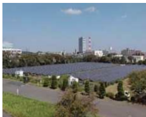
▲配水池上部の太陽光発電設備 (東村山浄水場)
