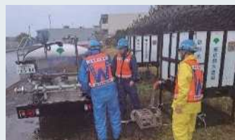
▲給水車から仮設給水槽への注水
