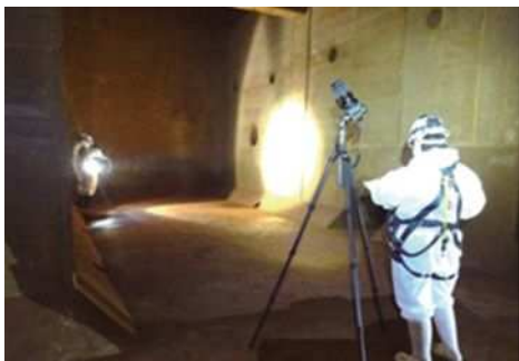
▲ひび割れ等損傷状況についての調査
