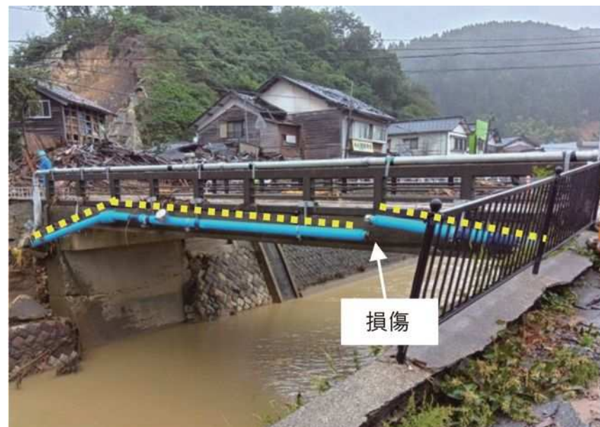
添架管の損傷(石川県)
