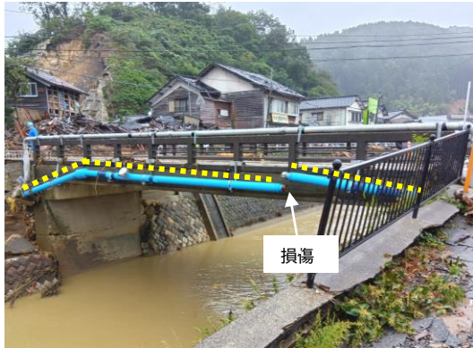
<添架管の損傷（石川県）>
