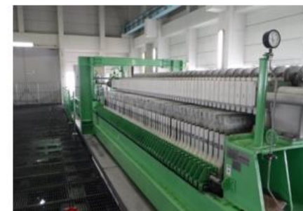
<排水処理設備（脱水機）>
