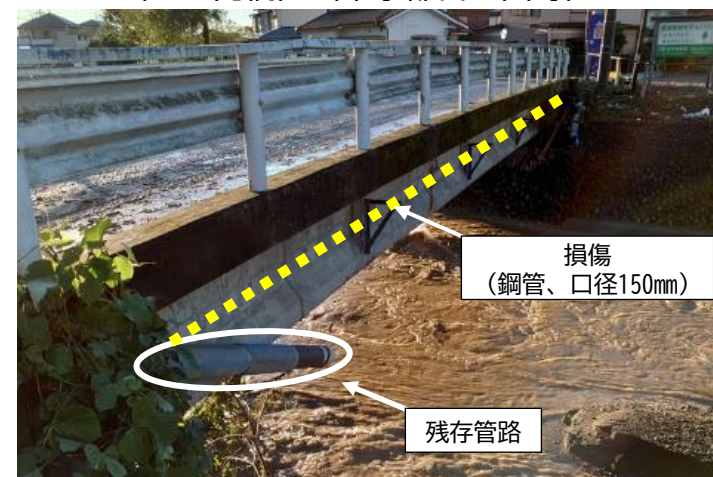
＜令和元年東日本台風による添架管の損傷 （玉の内橋）（東京都日の出町）＞
