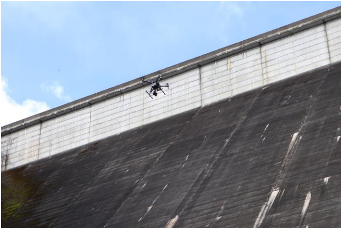
<ドローンによる貯水池堤体の点検>
