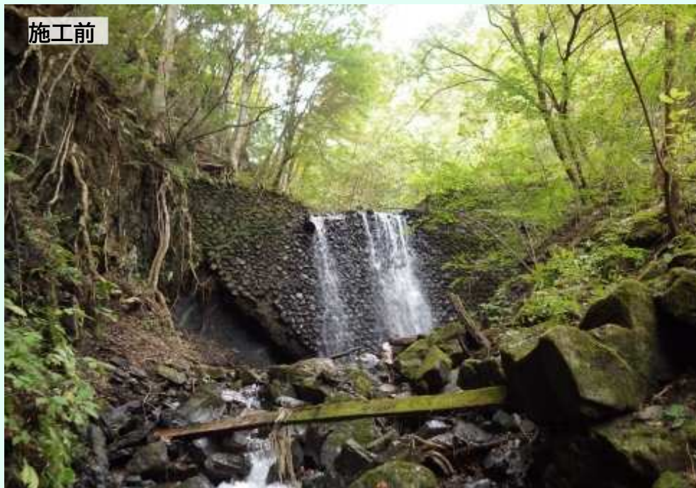
谷止工破損箇所の改修（増厚、嵩上げ）
