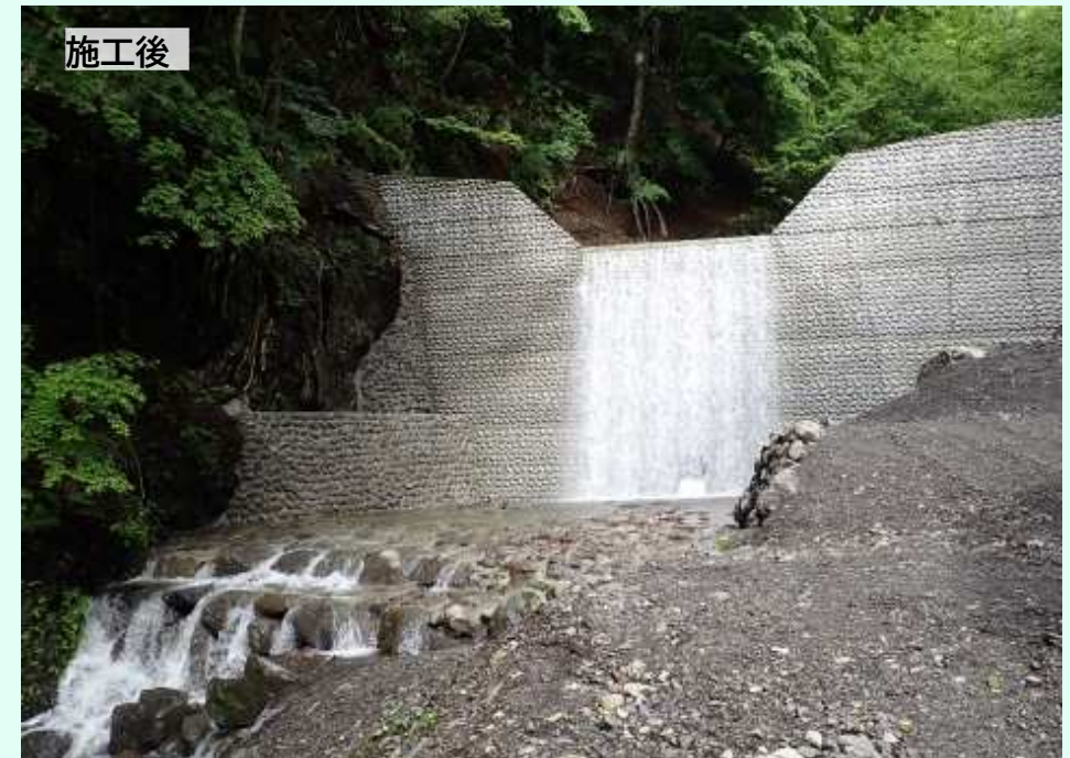
谷止工破損箇所の改修（増厚、嵩上げ）
