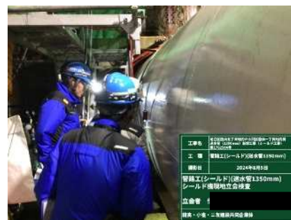
写真-8 現地組立検査状況
