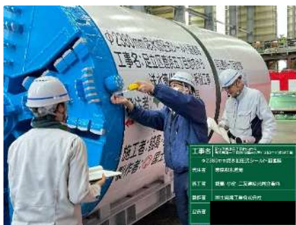
写真-7 工場検査状況
