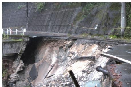
都道崩落による導水管損傷現場
