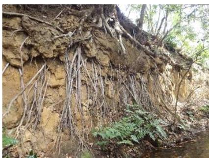
＜根系発達による表層の崩落＞
