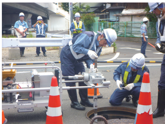
バルブを開け、連絡管をつなぐ訓練
