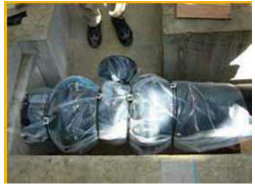
ポリエチレンスリーブによる配水管の腐食防止
