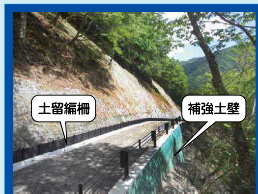
土留編柵、補強土壁
