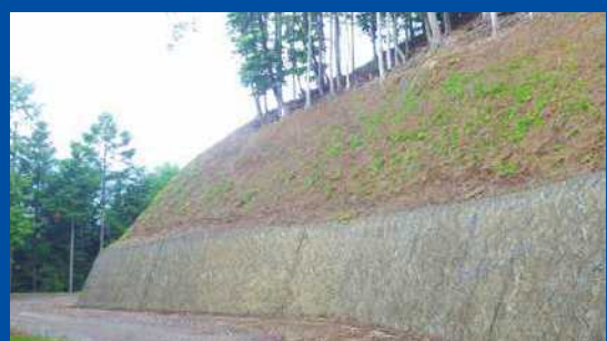
自然侵入促進型植生基材吹付 (施工後)
