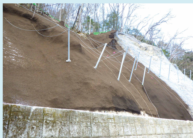
植生基材吹付工施工状況
