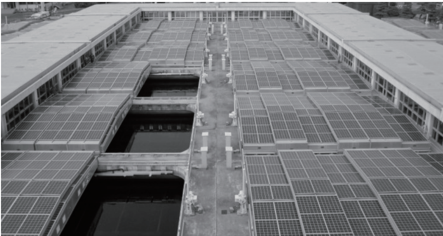
急速ろ過池（上部は覆蓋及び太陽光発電設備）
