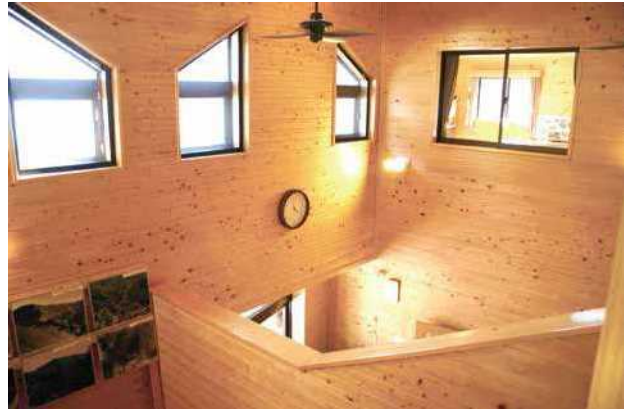
間伐材を利用した多摩川水源森林隊事務所の内装
