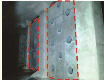
(補強後 (耐震壁の新設))
