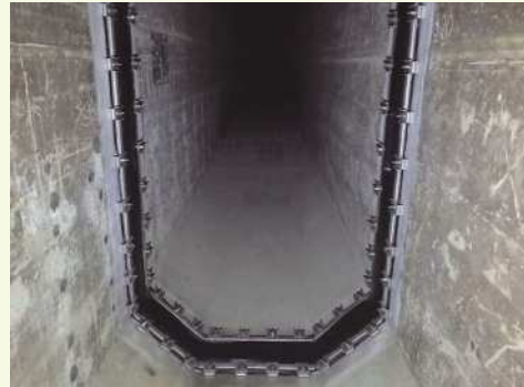
<三郷浄水場導水路の耐震化 (伸縮可とう継手の設置)>
