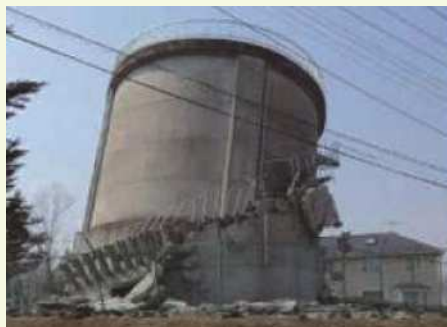
<東日本大震災の余震による配水塔の倒壊（岩手県）>
