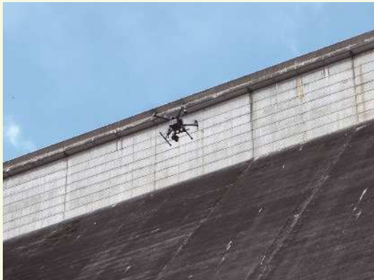
<ドローンによる貯水池堤体の点検>
