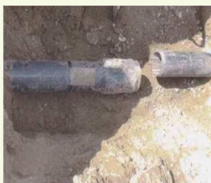
＜漏水した塩化ビニル製の給水管＞
