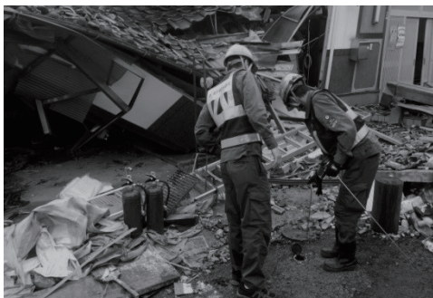
漏水調査（熊本県益城町）
