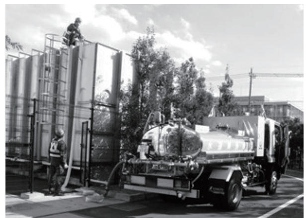
給水車からの高所揚水訓練
