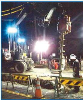
アースオーガで削孔中に地下埋設物を損傷させ、復旧まで長期間にわたり車線規制をしたことから渋滞が大規模に広がった。(R5年度)
