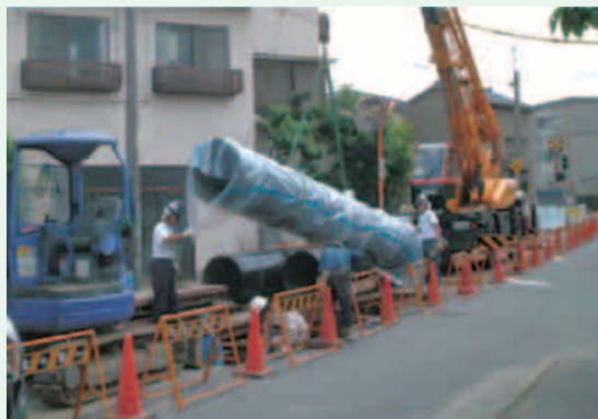
水道管路の取替工事
