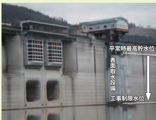
貯水位を下げて更新工事を実施
