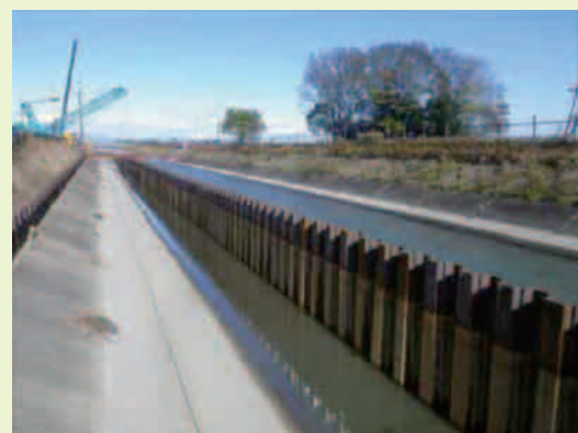
導水量を制限して改築工事を実施
