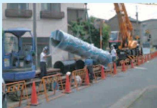
耐震継手管への取替工事
