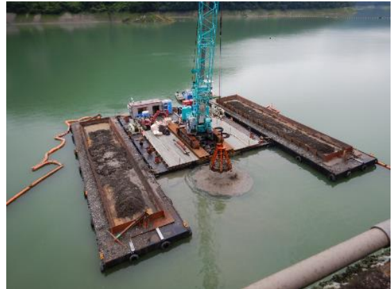
▲貯水池のしゅんせつ状況 (提供：(独)水資源機構)
