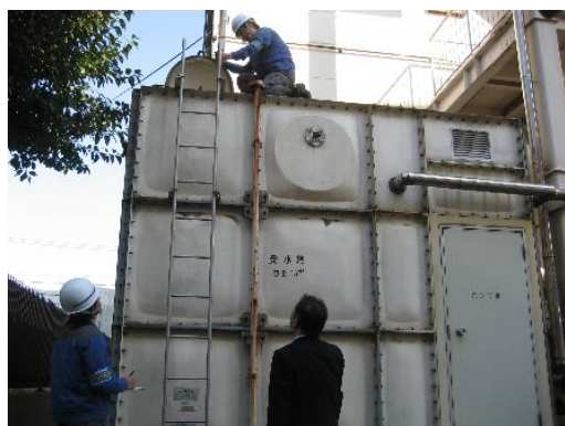
▲貯水槽水道の管理状況の確認
