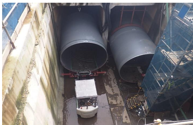
▲利根導水路大規模地震対策事業 (提供：(独)水資源機構)
