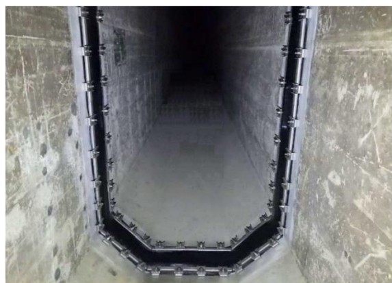
▲三郷浄水場導水路の耐震化 (伸縮可とう継手の設置)
