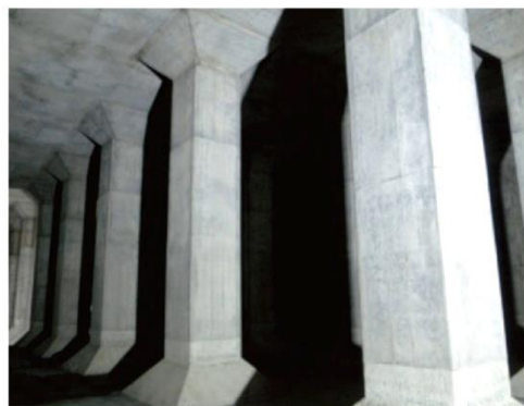
▲補強前の配水池
