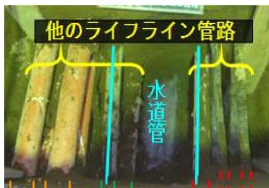
▲埋設物が輻輳している例
