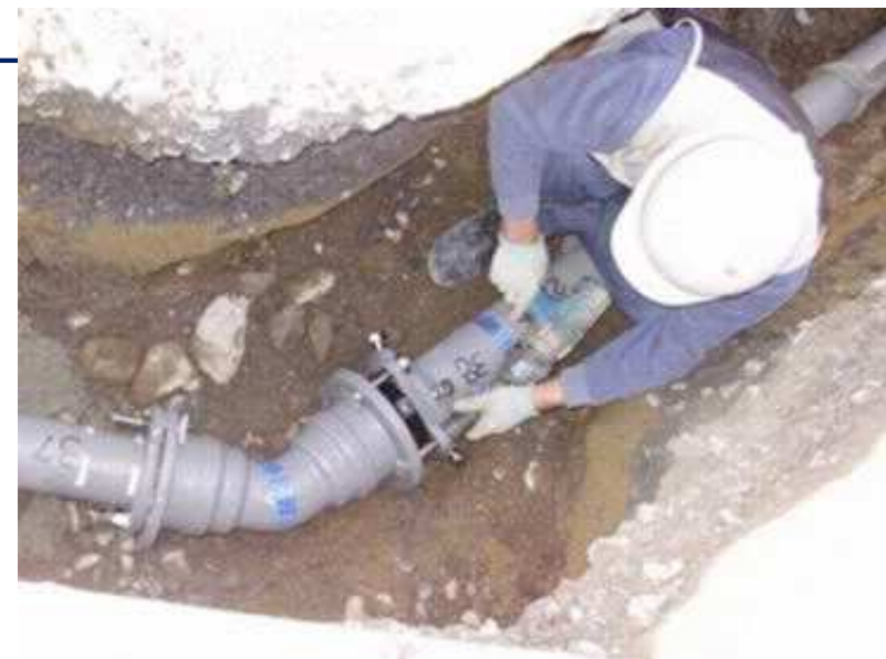
配水支管工事の施工
