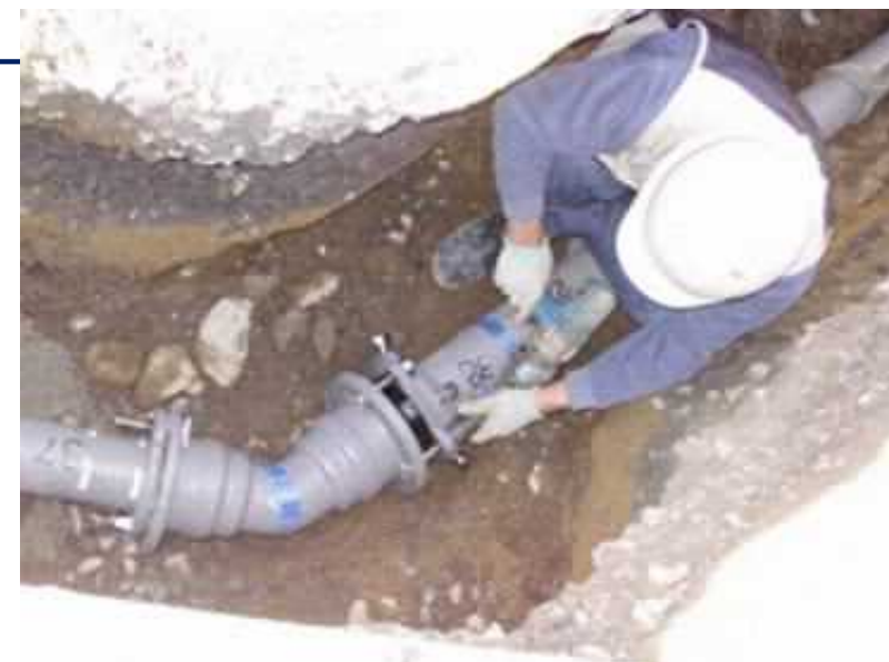
配水支管工事の施工
