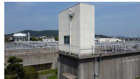
高所の外壁や配管イメージ
