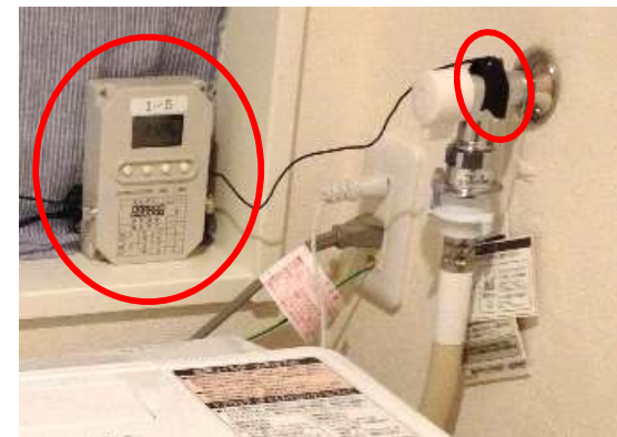
写真 測定機器設置の様子
