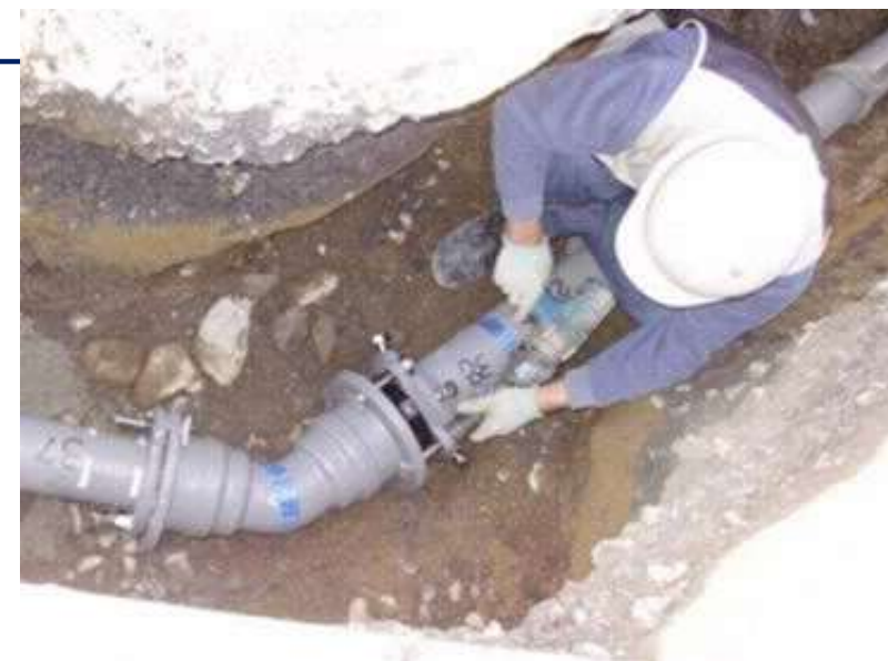
配水支管工事の施工
